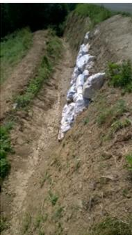
De même, le fossé du chemin des Habitants n'a pas été épargné par les pluies torrentielles. En effet plusieurs éboulements se sont produits mettant en danger la chaussée, des enrochements importants ont été nécessaires pour renforcer la chaussée et rendre le chemin des Habitants à la circulation. Le lotissement de Pibrac lui aussi a vu son lot de problème :
